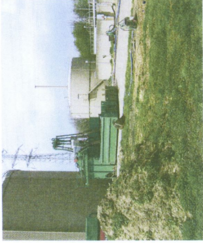
Ruimen slijgistingtank rwtz Roermond, 2.500 m 3 zand/slib/roostergoed mengsel.
