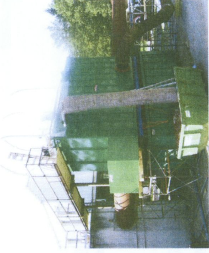
Inzet tijdelijke roostergoedontvangst en -ver- wijderingsinstallatie op de rwtz Boxtel.
