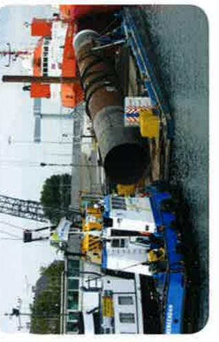
De toegepaste constructie bestaat uit een paal van Ø 3080mm, lengte van 40m en een gewicht van 90 ton. In de beschermpaal zijn 16 stuks spuitaasen en 4 luchtleidingen aangebracht om zonder trillingen de paal op diepte te brengen. De beschermpaal is door De Klerk Werkuitgbouw & Staalconstructie BV op de loswal te Woudrichem
