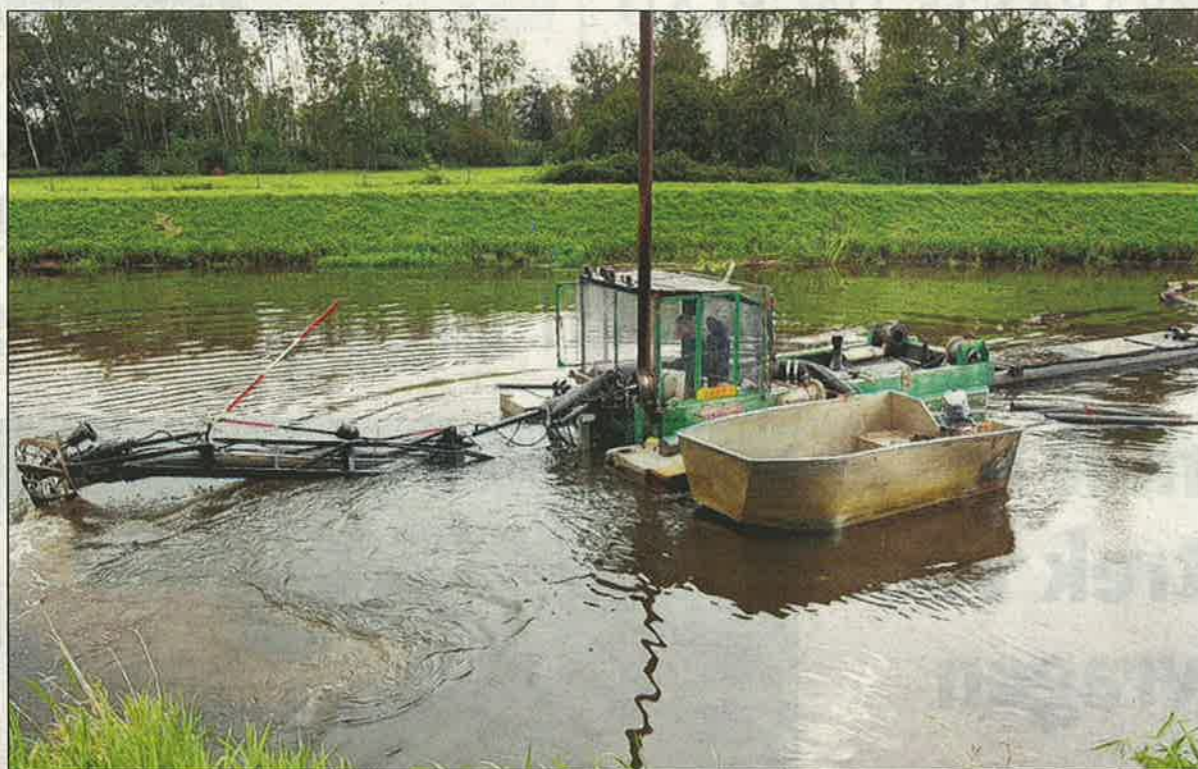
De baggermachinist werkt met een bodemtekening om het chroom uit de vervuilde rivierbedding van de Essche Stroom te halen. Op de foto is de stofzuigarm goed zichtbaar. foto Clemens Le Blanc
